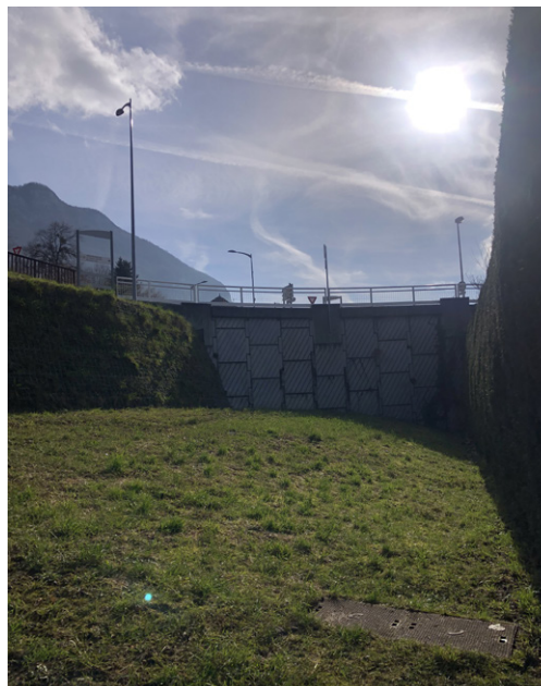
Photographie de l'état existant sous le giratoire : soutènement en terre armée
