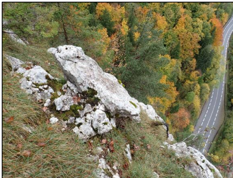
Masse de 6m 3
